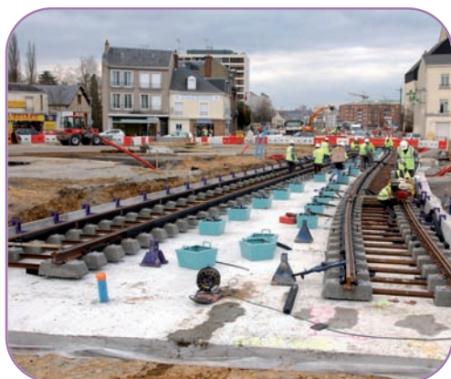
Travaux du Citadis, Le Mans
