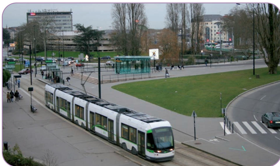
Ligne 1 du tramway, place de la Duchesse Anne, au croisement avec la ligne de BusWay, Nantes
